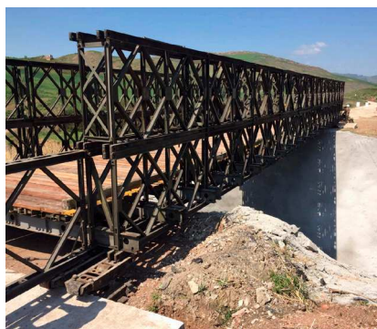
Il 4° Reggimento Genio Guastatori di Palermo realizza un ponte Bailey a Mussomeli (CL).
