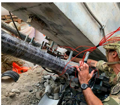
Fondamentale contributo degli Incursori dell'Esercito nella demolizione del ponte "Morandi" a Genova.
